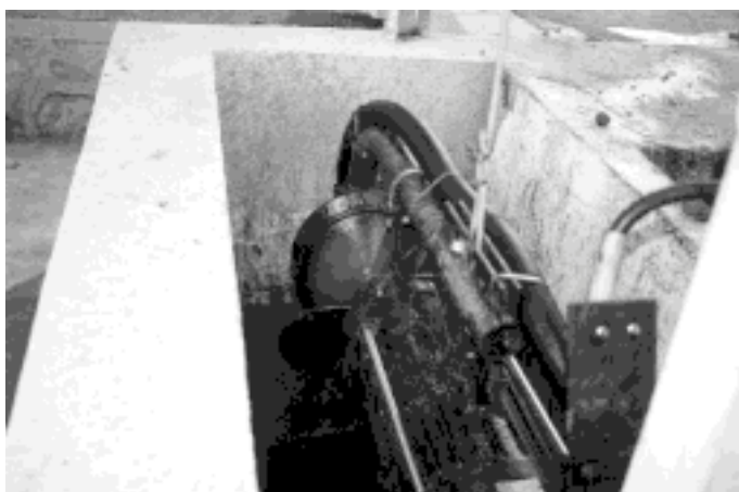
Aireador y agitador de purines para su homogeneización.
