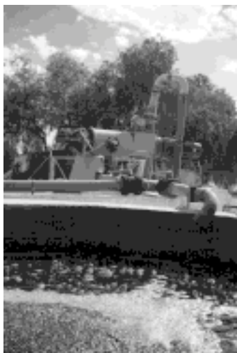
Aireación de la Fase líquida
