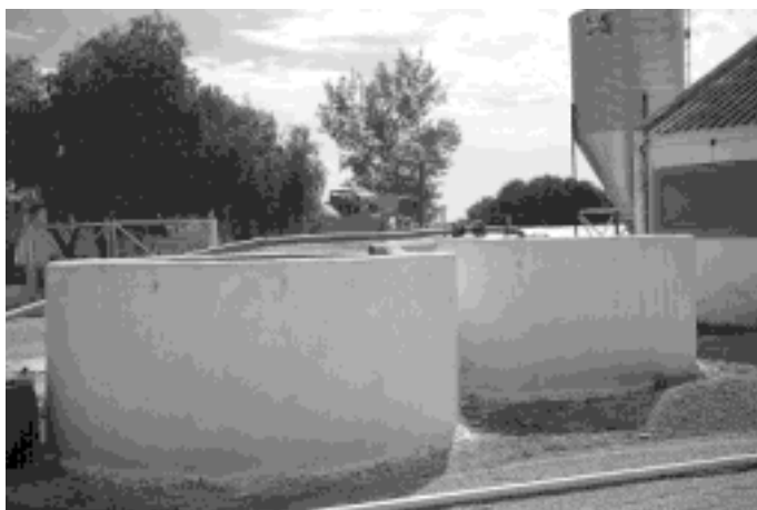
Vista parcial de los depósitos de almacenamiento de la Fase líquida
