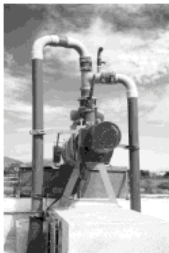
Vista posterior del separador de purines con las tuberías de alimentación del "compacter" y el sistema de retorno
