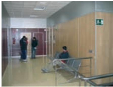
Tabiques de aglomerado de madera tratados con pintura ignífuga en la oficina del SEF de La Unión
