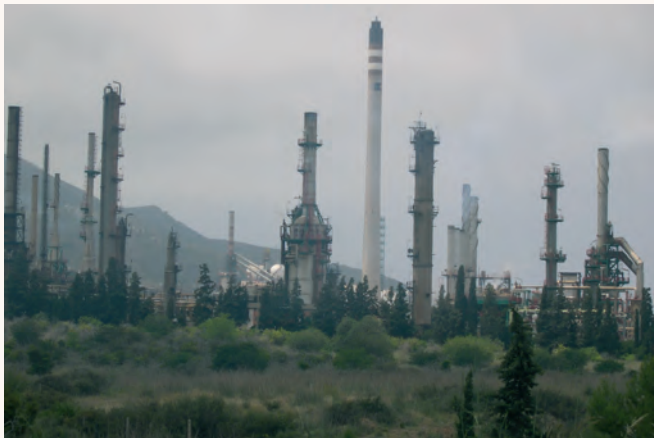
Instalaciones industriales del valle de Escombreras.
