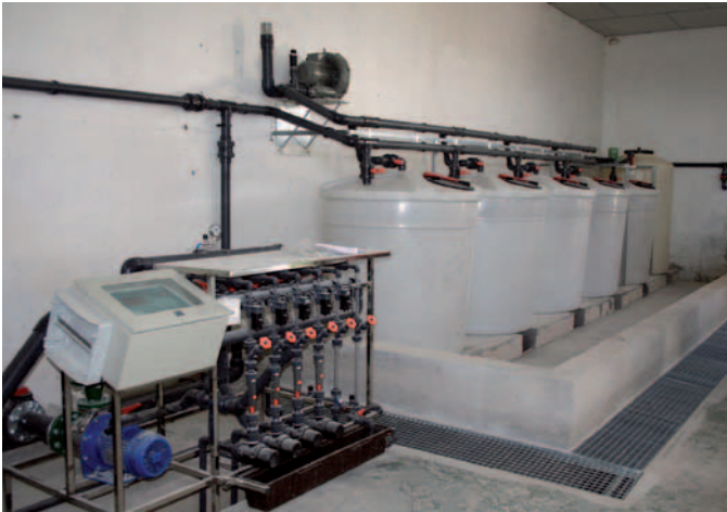
Instalaciones CDTA El Mirador (San Javier); Cabezal de riego y estación meteorológica.
