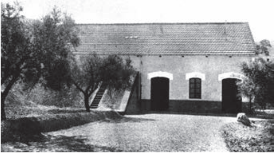
Fachada de la cámara frigorífica
