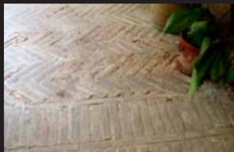
La degradación del material producida por erosión, es el daño más difícil de evitar. Esto se debe a que afecta a las zonas más expuestas de la envolvente del edificio.
