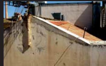
En cubierta, es muy común su presencia en antepechos y pretilas, cuyo acabado es un revestimiento continuo, generalmente pintura, en el que las importantes variaciones de temperatura (dilataciones-contracciones) acaban por fisurar el revestimiento.
