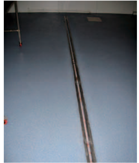
Canalización en suelo.
