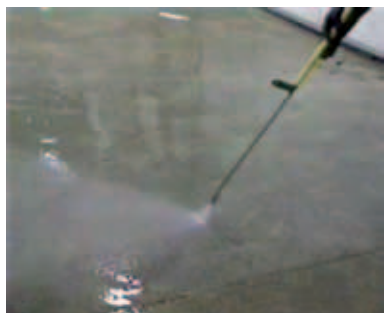
Limpieza con agua a presión.
