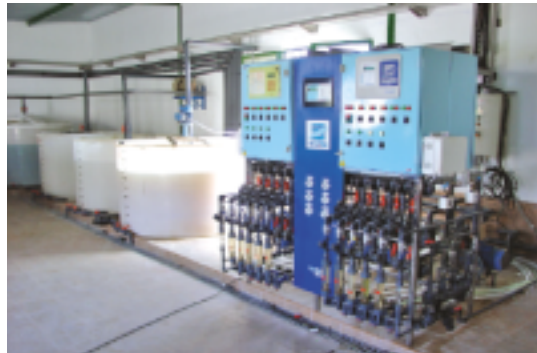
Fig. 2.1. Detalle del cabezal de riego.
