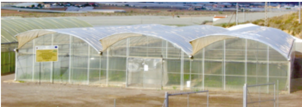
Fig. 2.2. Vista exterior del Invernadero Experimental nº 1.
