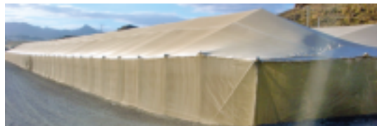
Fig. 2.7. Vista exterior de Malla experimental nº 1-A.
