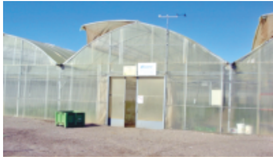
Fig. 2.3. Vista exterior del Invernadero experimental nº 2.
