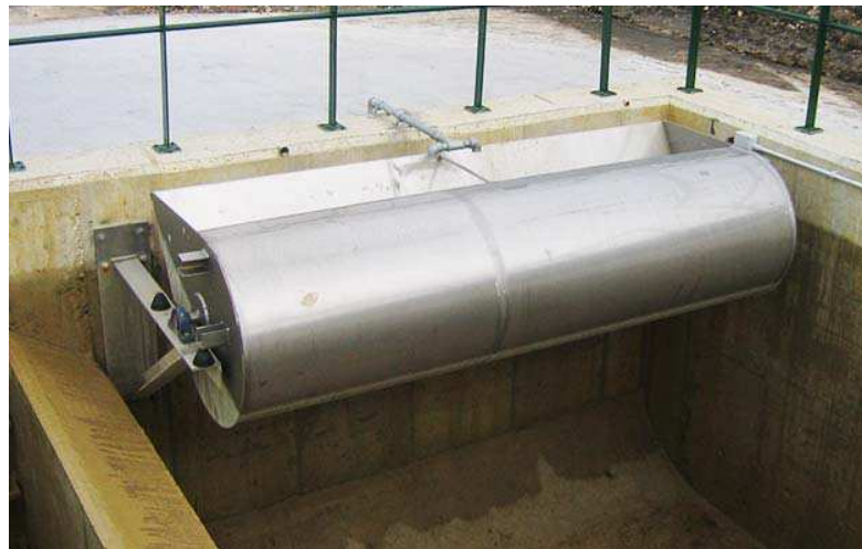
Figura 6.- Imagen de un volquete autobasculante para la limpieza del tanque de tormentas. (Fuente: Memoria del proyecto.
