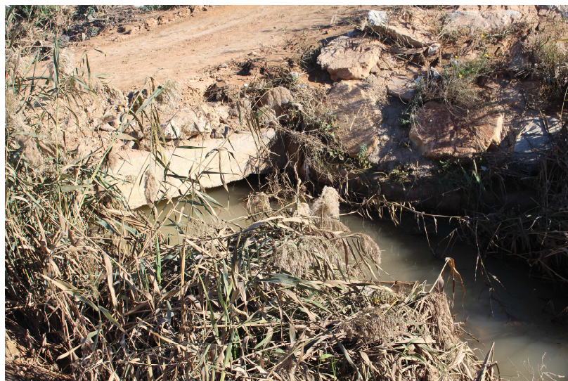
Fotografía 1. Aportes de aguas del Canal de drenaje D-7 a la rambla del Albuñón (04/12/2018).
