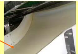
**Recubrimiento de los techos de la nave con lama de PVC para evitar la transmisión del ruido aéreo.**
