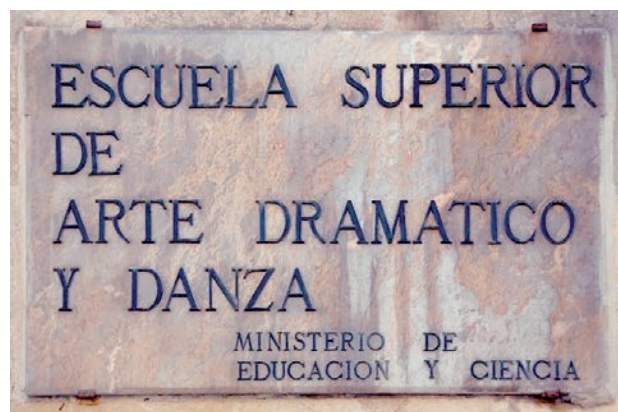
La placa original de 1986 se desprendió accidentalmente en 2019.
