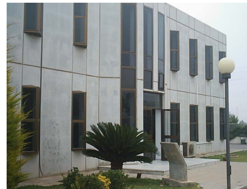
Sede del Centro Regional de Industria y Energía, donde se ubican actualmente las instalaciones del CIC. FOTO: CIC.
